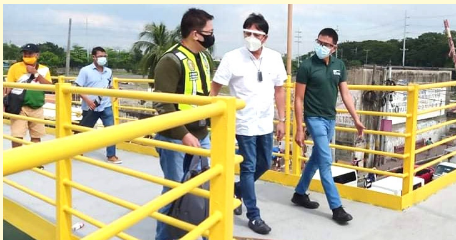
INSPECTION OF ON-GOING REHABILITATION OF BICUTAN BRIDGE: December 5, 2020 ay personal na nag inspeksyon si Parañaque City Mayor Edwin L. Olivarez kasama si Congressman Eric L. Olivarez sa ginagawang rehabilitation project ng Bicutan Bridge na madalas na ginagamit ng mga residente ng Lungsod ng Parañaque at Taguig. Kamakailan ay matatandaan na nagkaroon ng pagkakasira ang nasabing tulay na agaran namang inaksyunan at tinugunan ng Lungsod ng Parañaque sa pangunguna ni Mayor Edwin L. Olivarez sa pakikipagtulungan ng Metro Manila Development Authority (MMDA) upang masiguro ang kaligtasan ng mga mamamayan na araw-araw dumadaan dito. #SaDiyosSaTaoSerbisyonTotoo #sErbisyoLangPO
